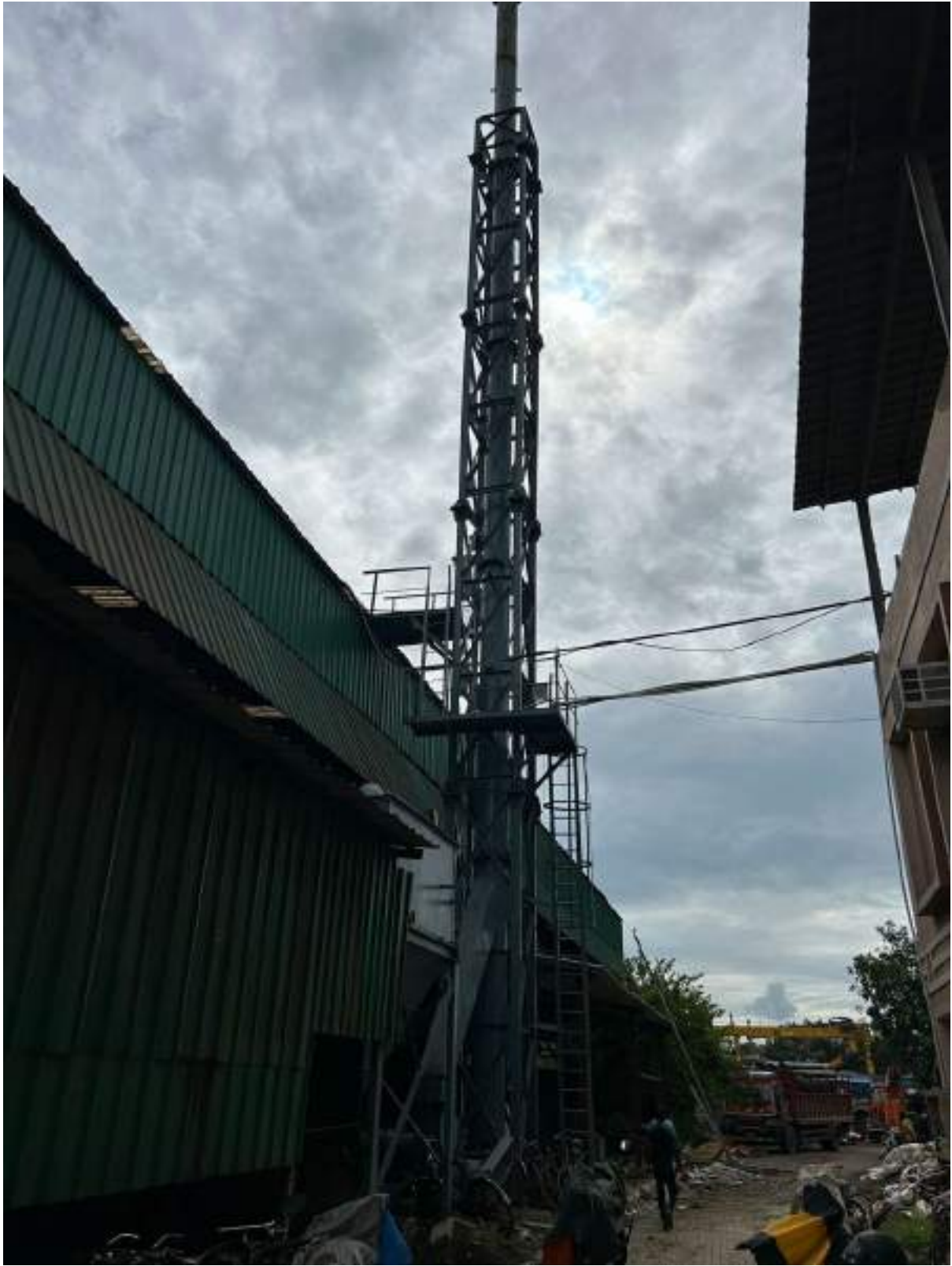
BITUMEIN COATING CHIMNEY
