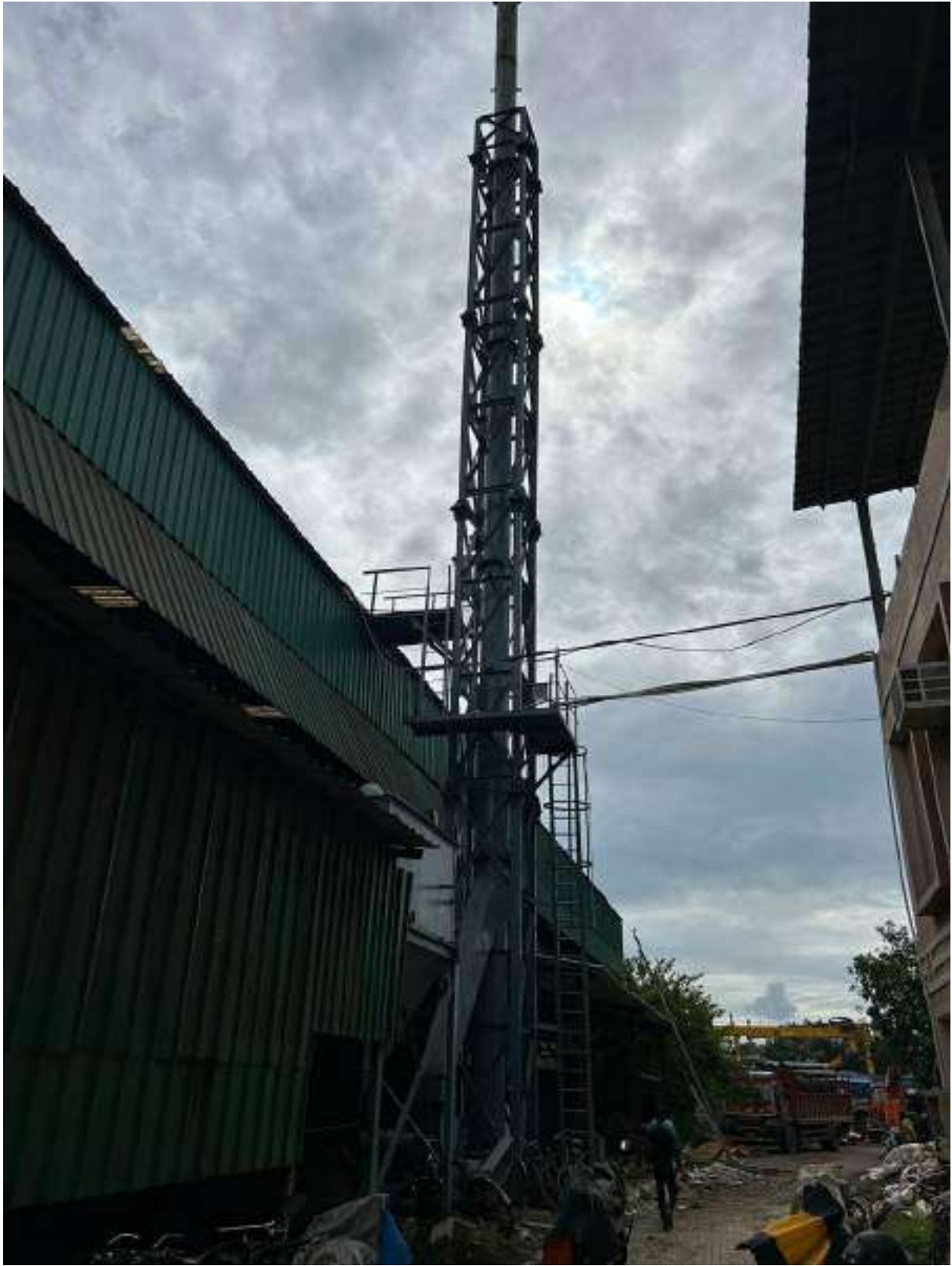
BITUMEIN COATING CHIMNEY
